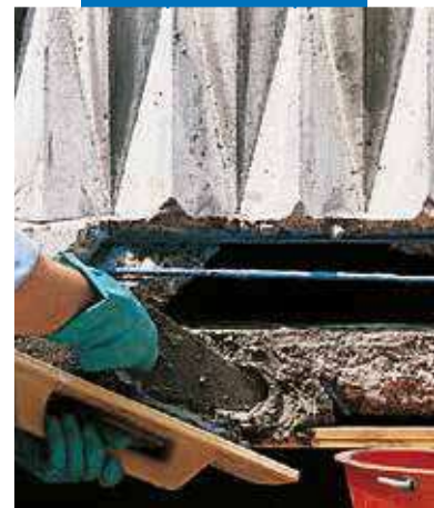
Balkono remontas naudojant Mapegrout T40
